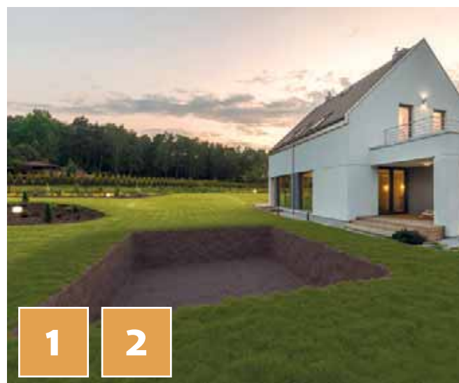
1 2 TERRASSEMENT ET CONTRÔLE DES NIVEAUX
